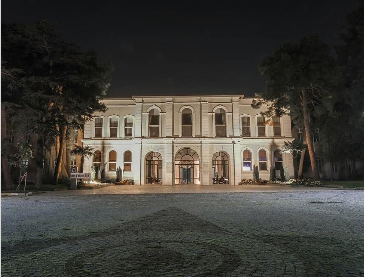
YTÜ Taş Kışla Binası, Davutpaşa Yerleşkesi
